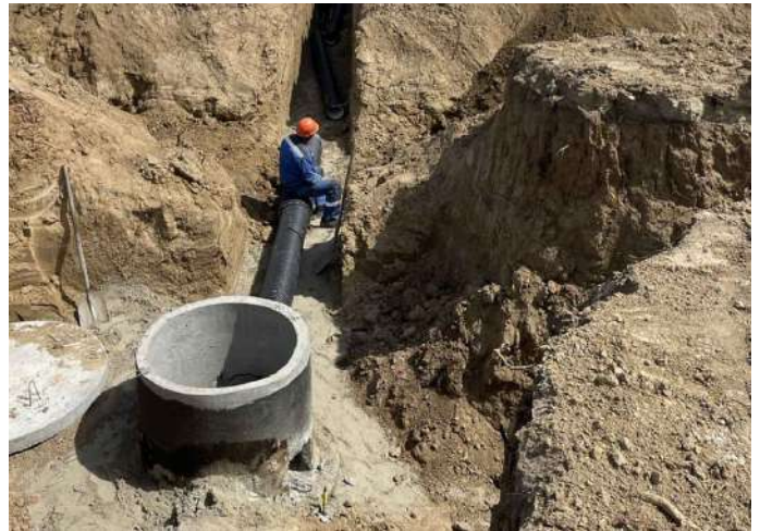
Объект: Строительство Логопарка, г. Омск Подрядчик: ООО РСК «Реновация»
