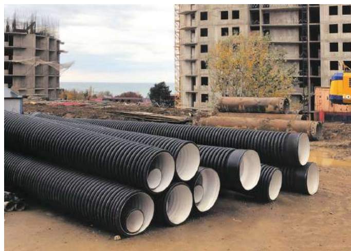
Объект: Жилой комплекс «Морская симфония», г. Сочи Подрядчик: ООО «Агора»
