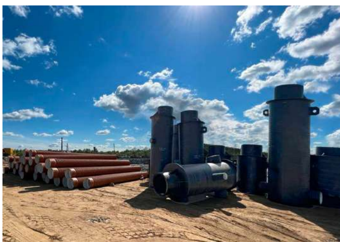
Объект: Строительство логистического центра, г. Екатеринбург Подрядчик: ООО «РегионТрубКомплект»
