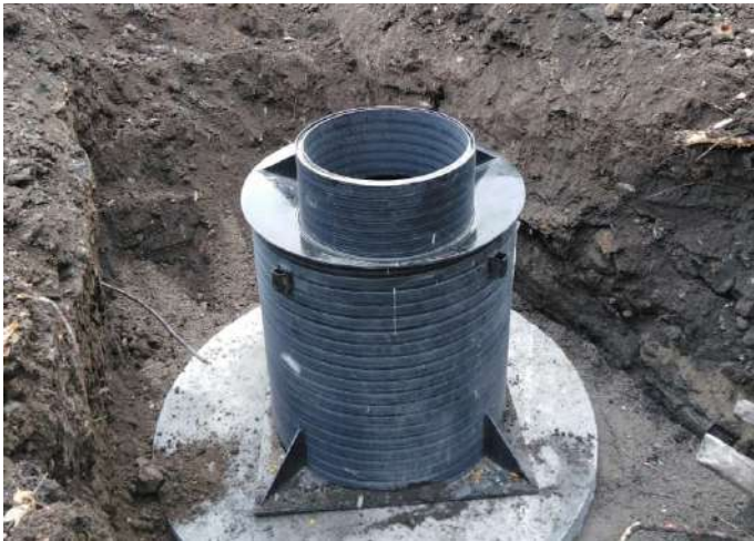
Объект: Реконструкция производственной площадки ООО «Техно-кластер», Кемеровская область, г. Новокузнецк Подрядчик: ООО «Рускомплект»
