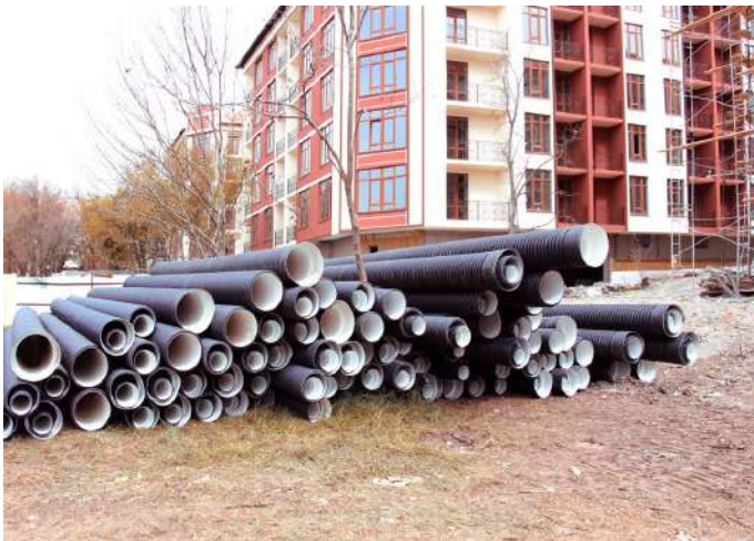
Объект: Прокладка коммуникаций, г. Геленджик Подрядчик: ООО «СМ-Строй»
